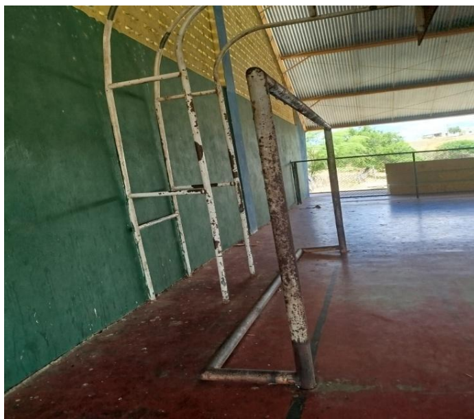
Figura 7 -Trave metálica com corrosão visível na quadra da Vila Caiçara.
