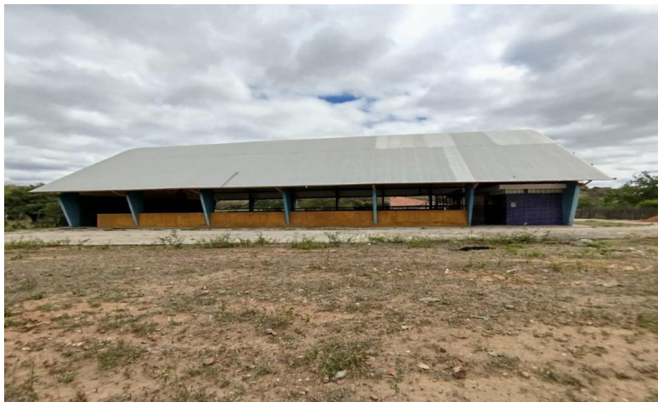
Figura 6 – Vista geral da quadra poliesportiva da Vila Caiçara (Paraná-RN).
