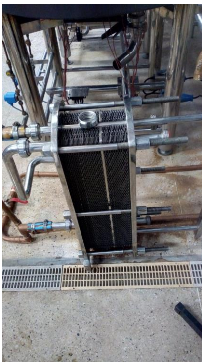
Figura 6. Trocador de calor por placas (Autoria Própria, 2019).
