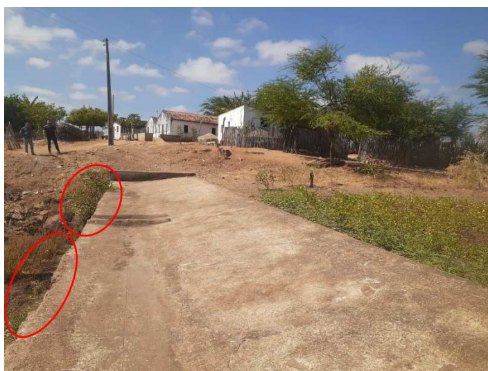
Figura 14: Vertedouro da barragem Angicos.
