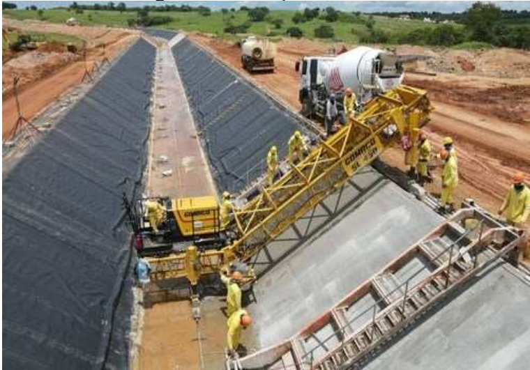
Figura 6: Execução do canal.
