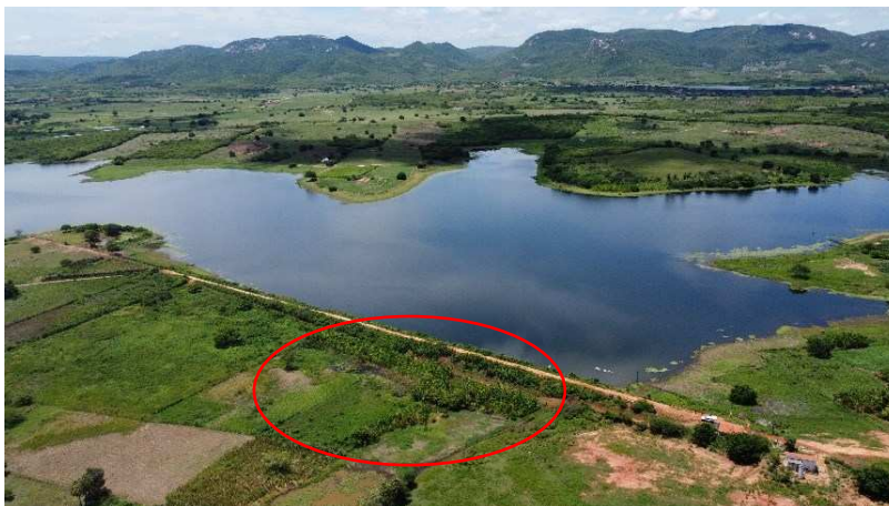
Figura 16: Anomalia aparente na Barragem Angicos.
