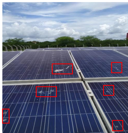
Figura 9: Módulos fotovoltaicos com dejetos de pássaros.
