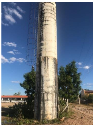
Figura 13 - Reservatório da Comunidade de Água Santa
