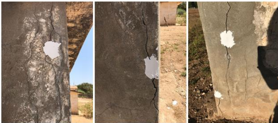
Figura 11 - Aplicação de gesso nas fissuras.
