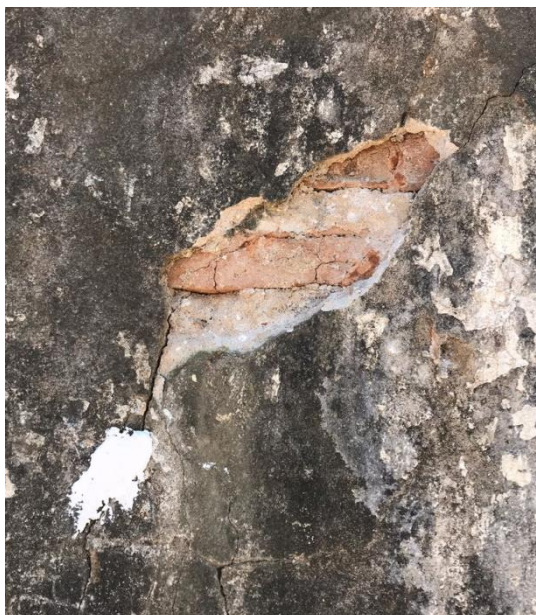
Figura 12 - Abertura da janela de inspeção
