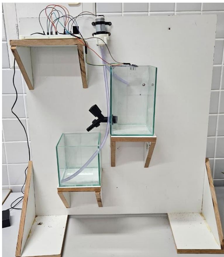
Figura 9 - Vista frontal da automação de tanques.
