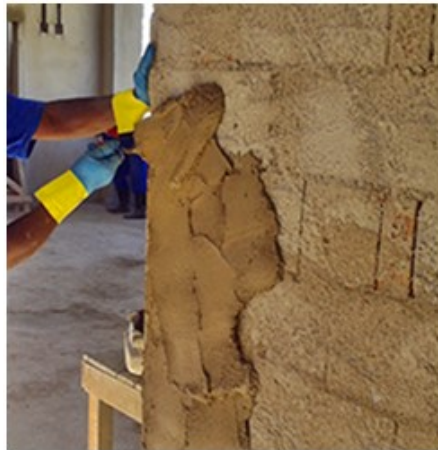
Figura 4 – Adesão inicial da argamassa.
