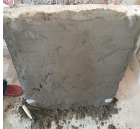
Figura 40 – Aplicação de argamassa padrão em placa de alvenaria.
