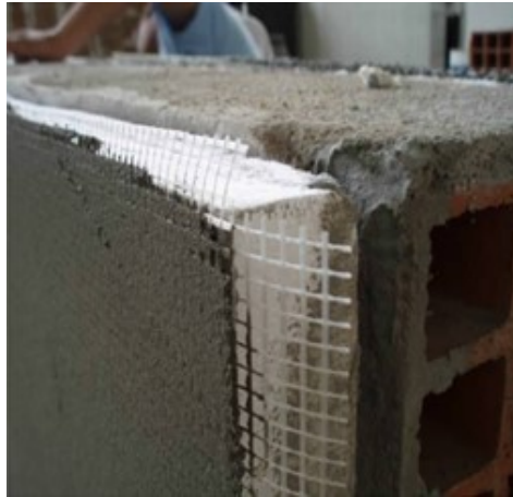
Figura 13 – ETICS com fixação por colagem.
