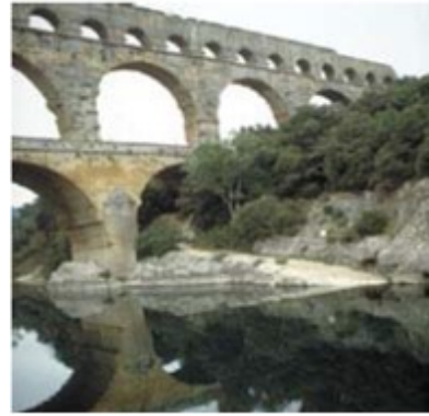
Figura 2 – Arqueduto de Pont-du-Gard
