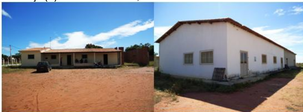
FIGURA 01 – Cooperativa: setor administrativo (A) e unidade de beneficiamento da castanha de caju (B). Serra do Mel-RN, 2014.
