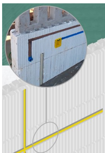
Figura 18 – Instalações elétricas e hidrossanitárias
