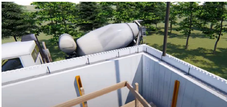
Figura 17 – Preparação para laje
