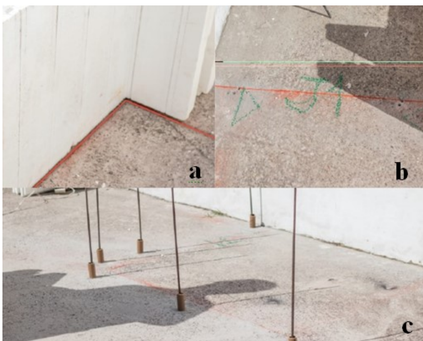
Figura 12 – Marcação dos blocos na base, marcação das aberturas e fixação dos arranques.
