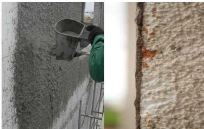
Figura 21 – Chapisco e reboco em parede ICF.
